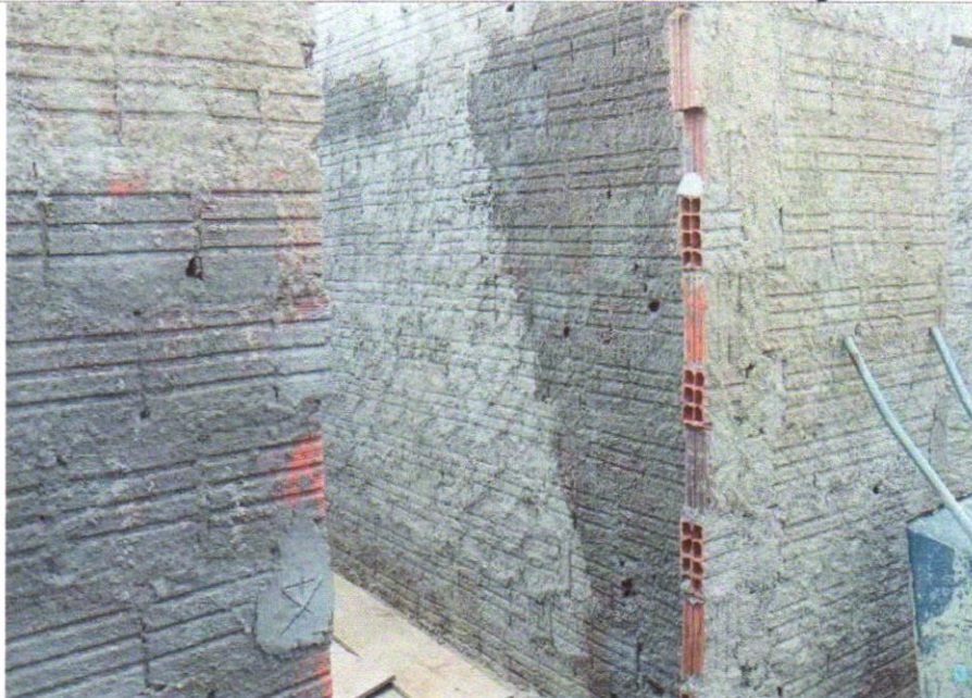
FOTO 11 – CHAPISCO APLICADO EM ALVENARIA (COM PRESENÇA DE VÃOS) E ESTRUTURAS DE CONCRETO DE FACHADA, COM EQUIPAMENTO DE PROJEÇÃO. ARGAMASSA TRAÇO 1:3 COM PREPARO EM BETONEIRA 400 L. AF_06/2014
