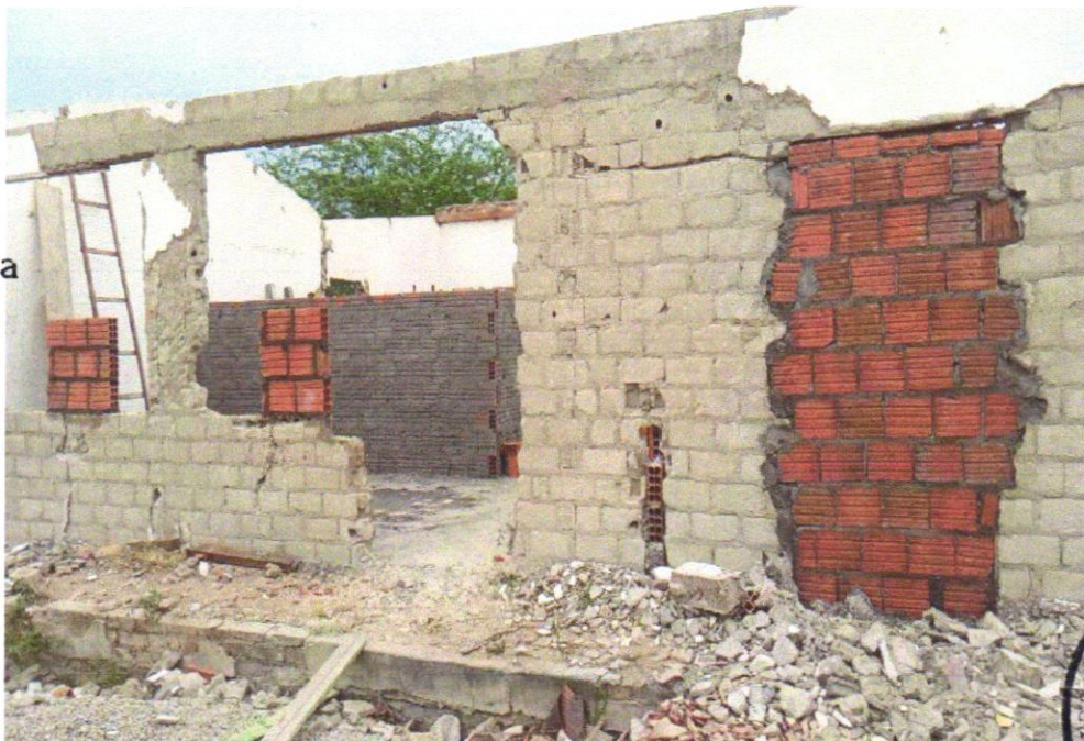
FOTO 06 – ALVENARIA DE VEDAÇÃO DE BLOCOS CERÂMICOS FURADOS NA HORIZONTAL DE 9X19X29 CM (ESPESSURA 9 CM) E ARGAMASSA DE ASSENTAMENTO, COM PREPARO EM BETONEIRA. AF_12/2021
