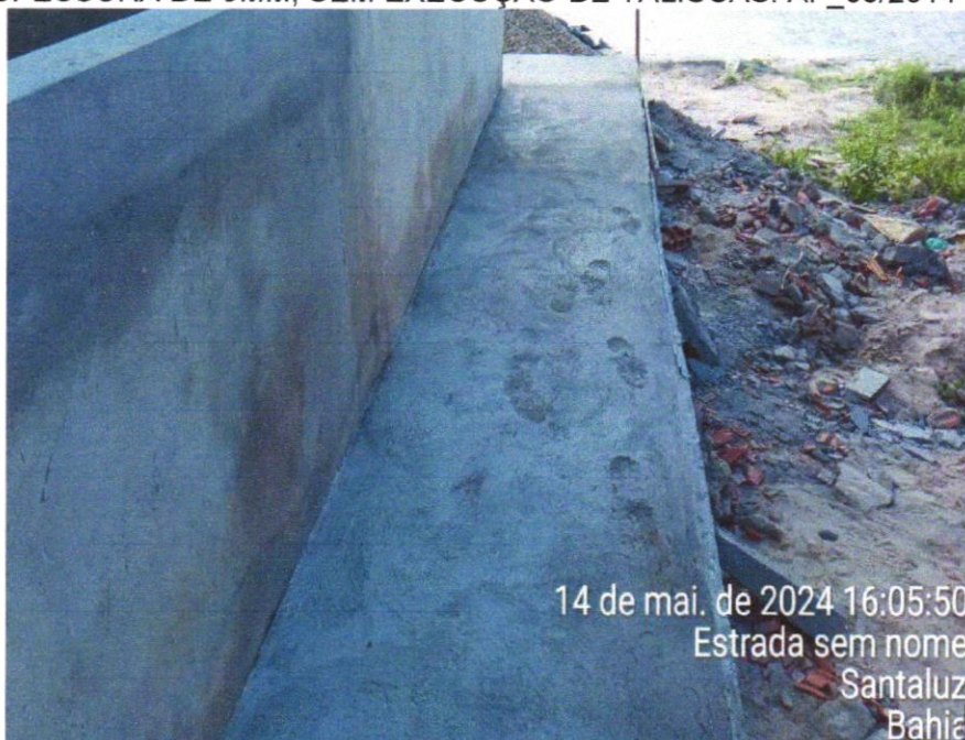
FOTO 14 - EXECUÇÃO DE PASSEIO (CALÇADA) OU PISO DE CONCRETO COM CONCRETO MOLDADO IN LOCO, USINADO, ACABAMENTO CONVENCIONAL, NÃO ARMADO. AF_07/2016
