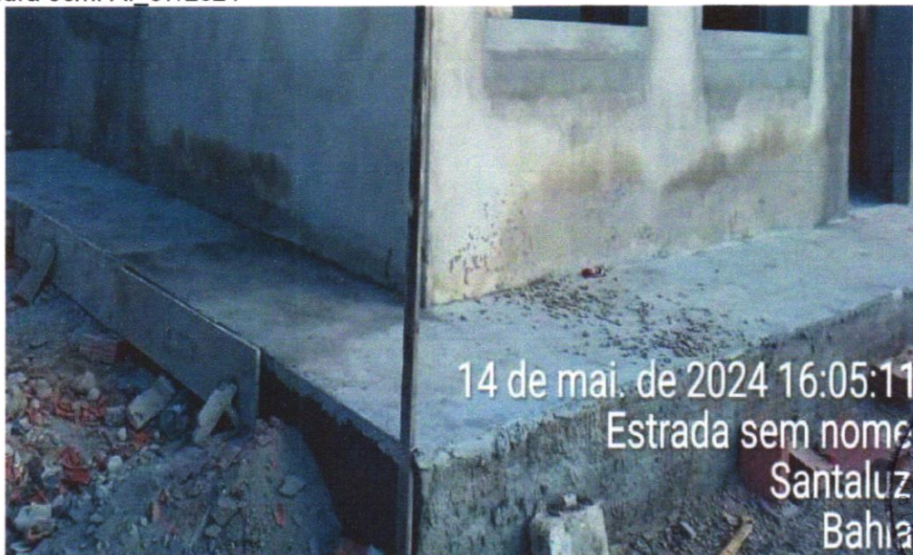
FOTO 18 – Contrapiso em argamassa traço 1:4 (cimento e areia), preparo mecânico com betoneira 400l, aplicado em áreas secas sobre laje, não aderido, acabamento não reforçado, espessura 5cm. Af_07/2021
