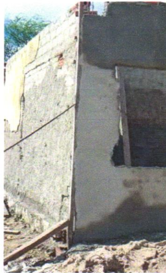
FOTO 05 – COMPOSIÇÃO REPRESENTATIVA) EXECUÇÃO DE ESTRUTURAS DE CONCRETO ARMADO, PARA EDIFICAÇÃO HABITACIONAL UNIFAMILIAR TÉRREA (CASA EM EMPREENDIMENTOS) FCK=25MPÁ. AF_01_01/2017
