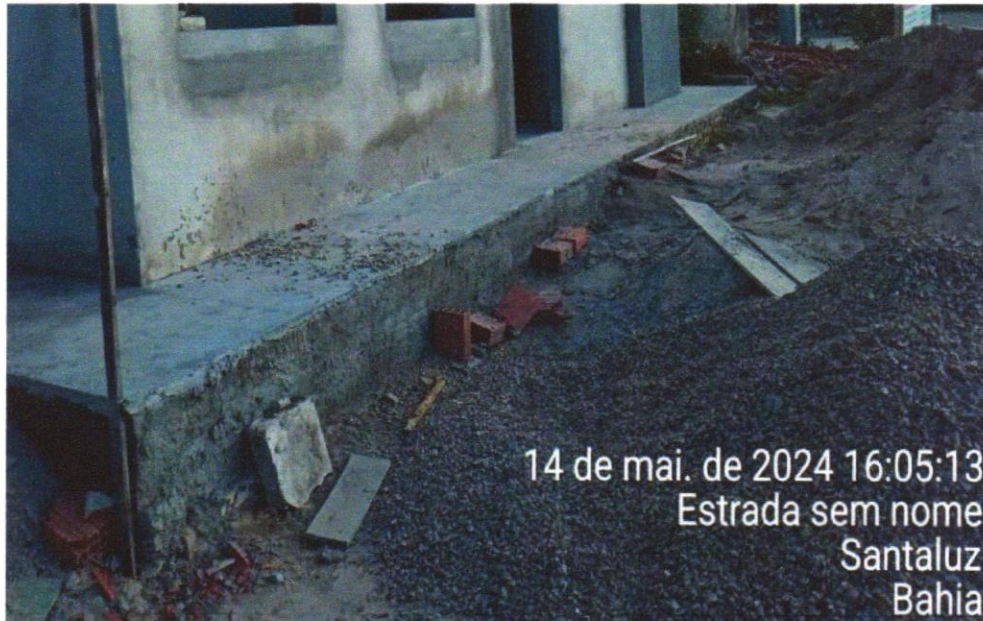
FOTO 15 - EXECUÇÃO DE PASSEIO (CALÇADA) OU PISO DE CONCRETO COM CONCRETO MOLDADO IN LOCO, USINADO, ACABAMENTO CONVENCIONAL, NÃO ARMADO. AF_07/2016
